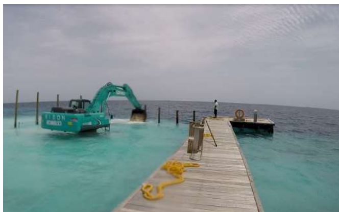
Engin de chantier évoluant sur le récif barrière
